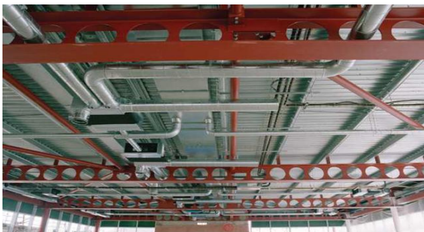
Figura 18 - Interação da estrutura com instalações técnicas
