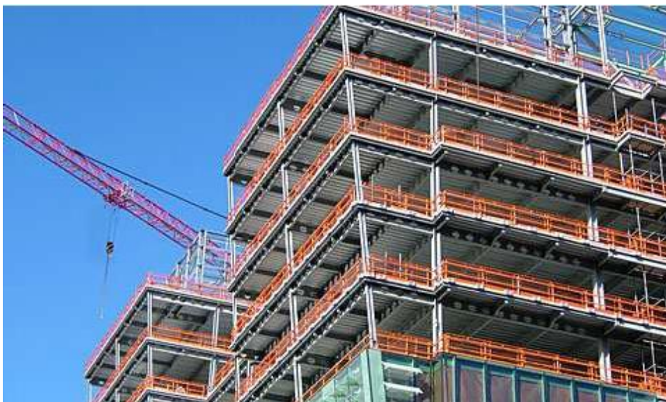
Figura 17 - Edifício de múltiplos andares com vigas alveolares do tipo celular
