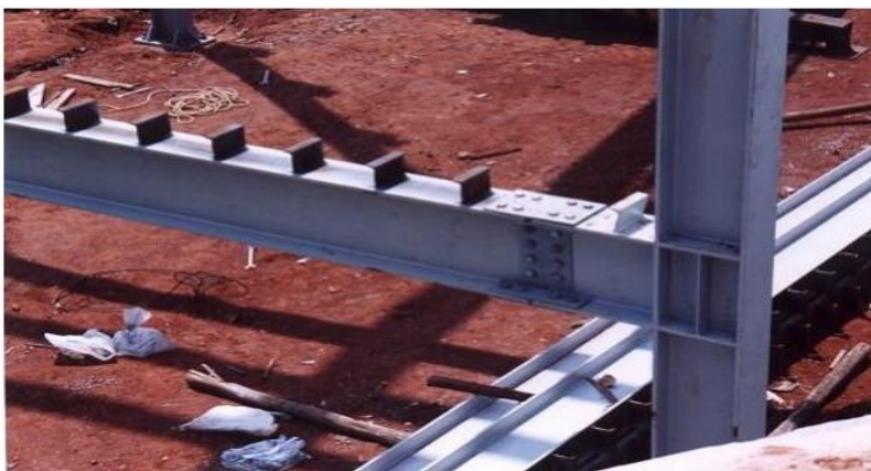
Figura 35 - Conector U soldado às vigas em um canteiro de obras
