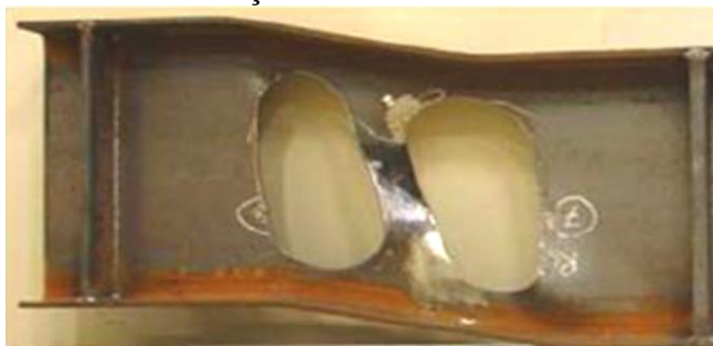
Figura 18 - Formação de rótula plástica devido a esforço de cisalhamento
