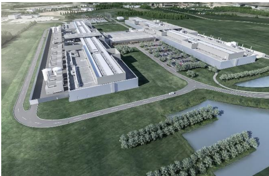
Data center em Odense (Dinamarca)
