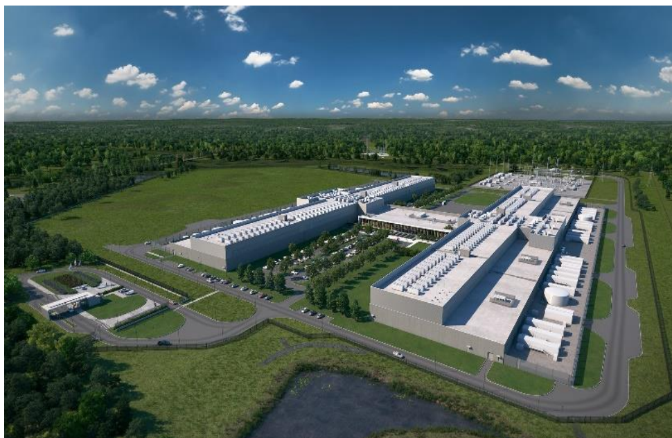
Data center Henrico no estado da Virgínia (EUA)
