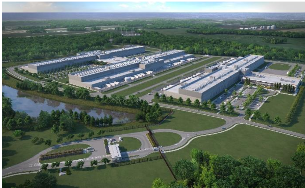
Data center New Albany no estado de Ohio (EUA)
