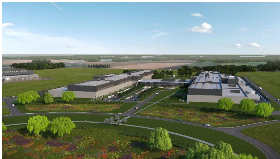
Data center em Altoona no estado de Iowa (EUA)
