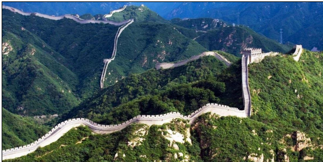
Figura 4 - Muralha da China
