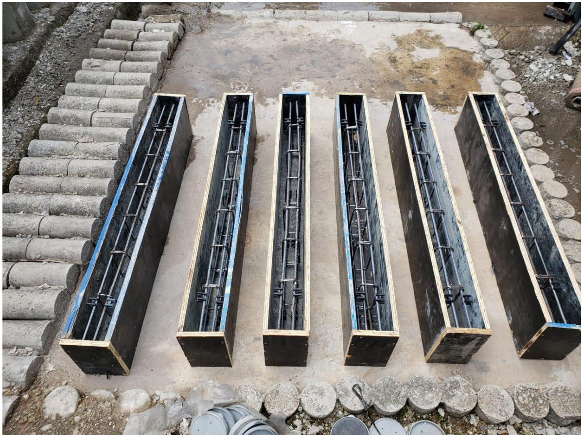
Figura 37 - Fôrmas com armaduras posicionadas, prontas para a concretagem.
