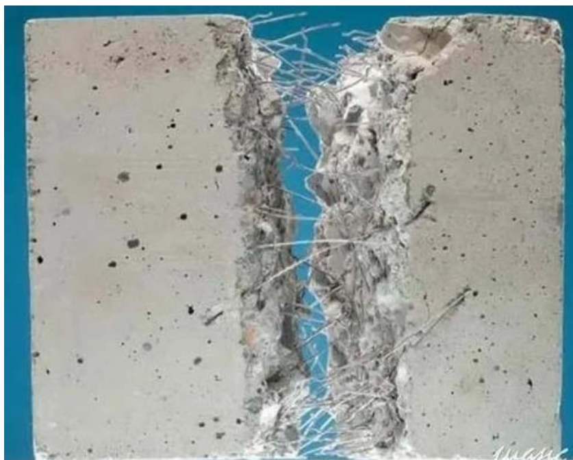
Figura 33 - Estrutura de concreto com reforço de fibra de PRFC
