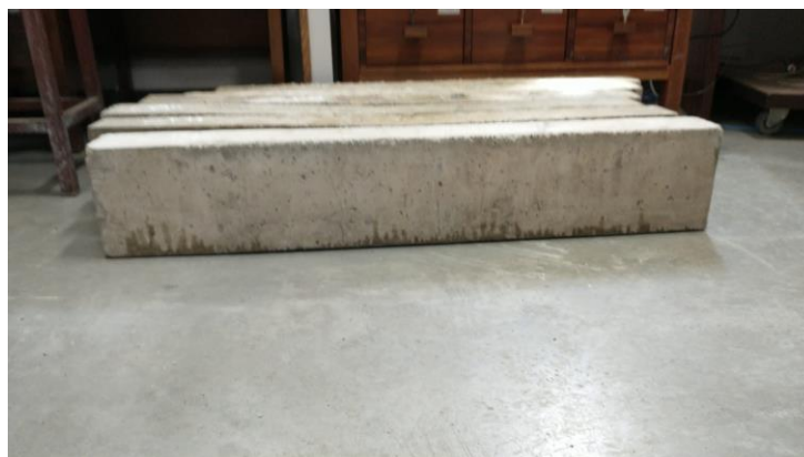
Figura 68 - Fissuração sob carregamento máximo CP 09
