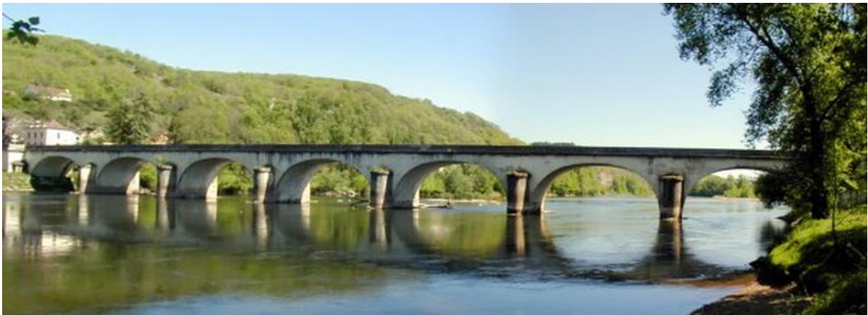
Figura 6 – Ponte de Souillac
