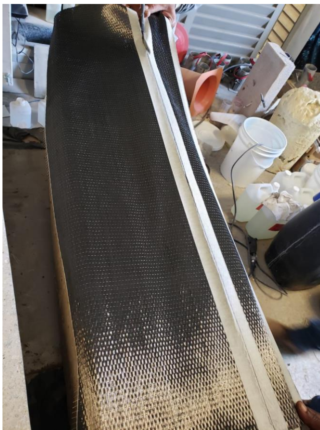
Figura 42 - Realização dos cortes da manta de PRFC.
