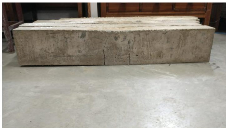
Figura 56 - Fissuração sob carregamento máximo CP 03
