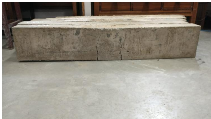
Figura 60 - Fissuração sob carregamento máximo CP 05
