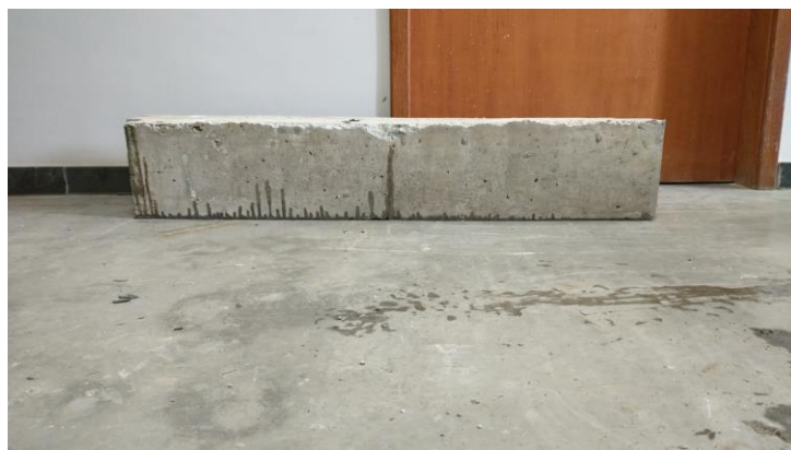
Figura 72 - Fissuração sob carregamento máximo CP 11
