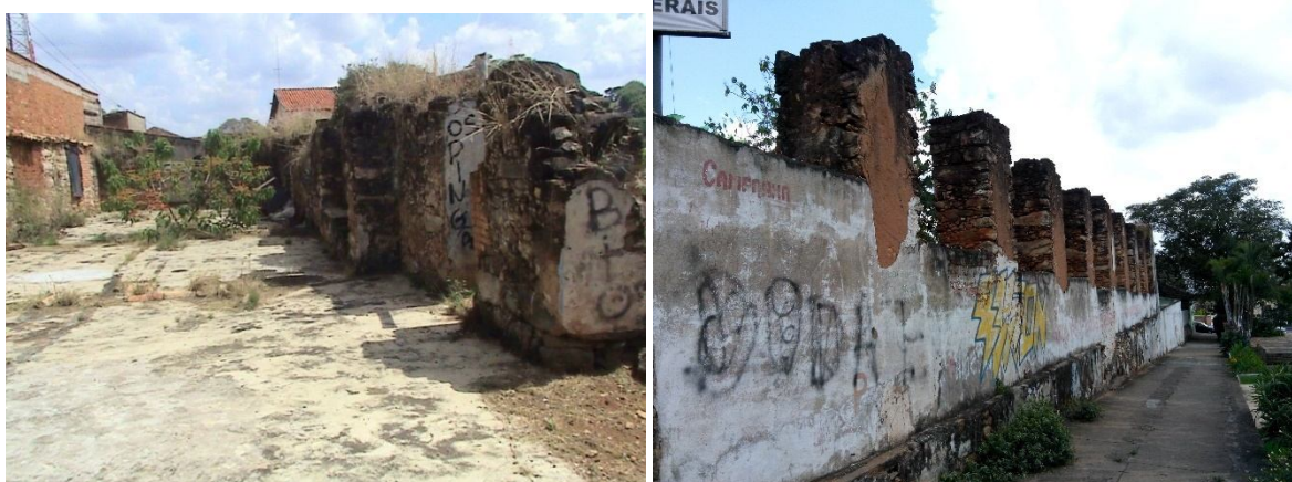
Figura 62 – Ruínas do que sobrou após o incêndio
