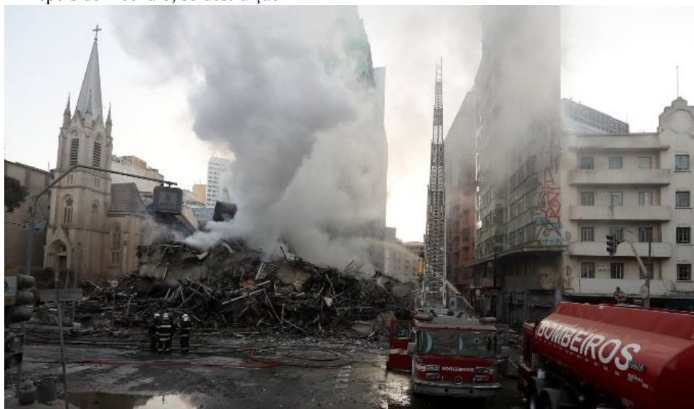
Figura 67 – Depois do incêndio, só destruição
