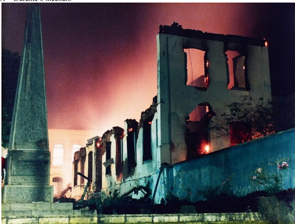
Figura 61 – Durante o incêndio
