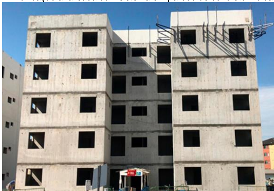
Figura 27 - Edificação analisada com sistema em parede de concreto moldado in loco
