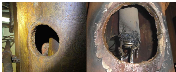
Figura 7: Exemplo de janela de visita em i-tube
