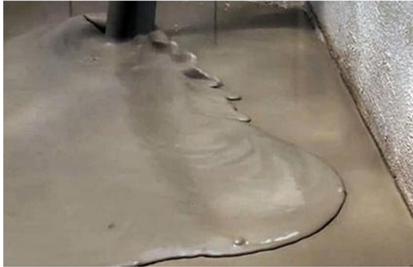
Figura 18. Contrapiso autonivelante.
