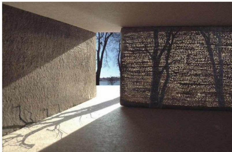
Figura 19. Concreto Translúcido.
