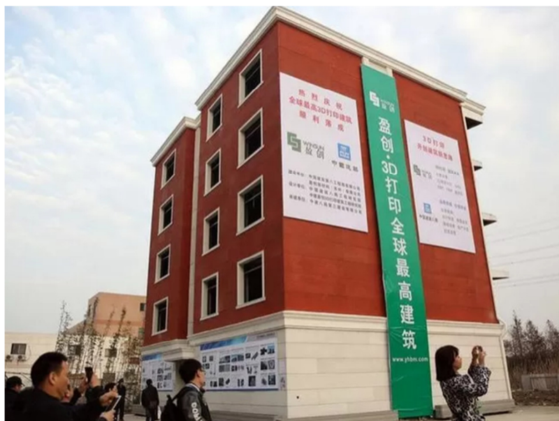
Figura 16. Primeiro edifício do mundo construído com uma impressora 3D. Fonte: Techtudo, 2015.
