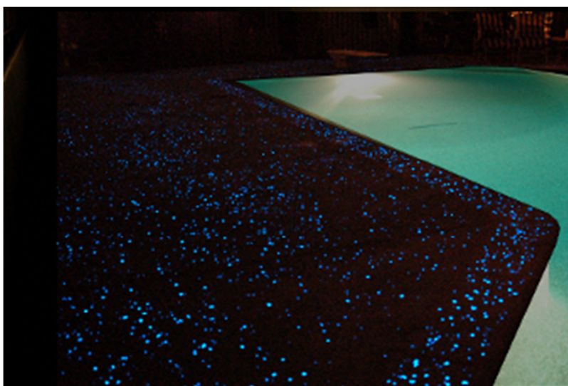
Figura 20. Concreto que brilha no escuro.
