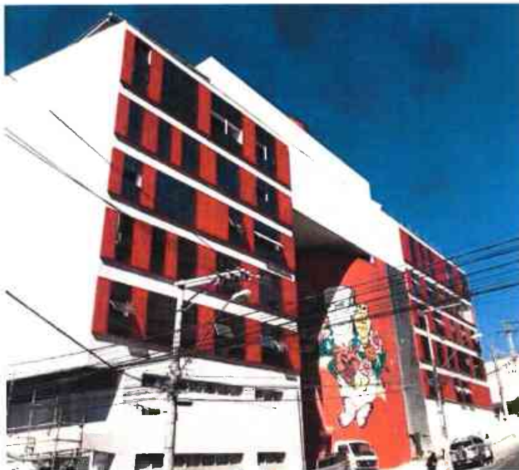
Figura 42 – Fachada da escola após remoção dos revestimentos e preparo da superfície (vista da Rua Sizenando de Barros)
