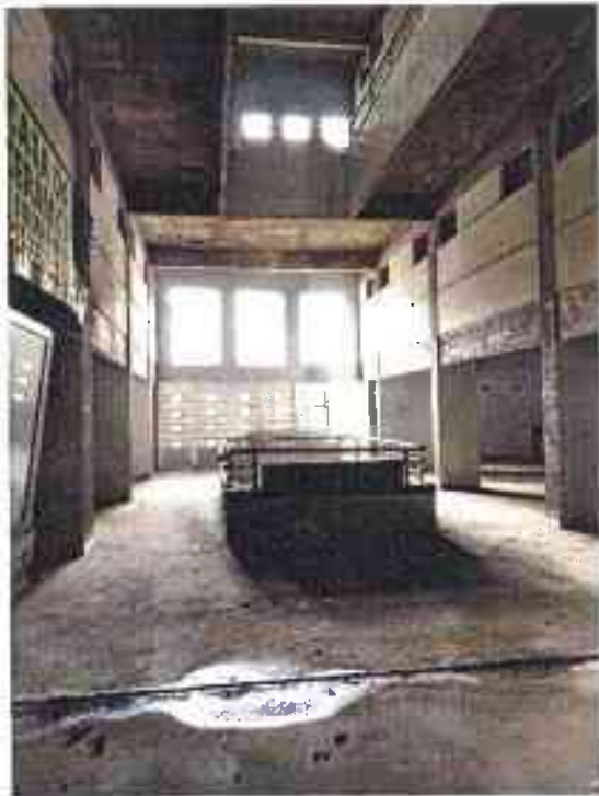
Figura 24 – Hall principal do edifício
