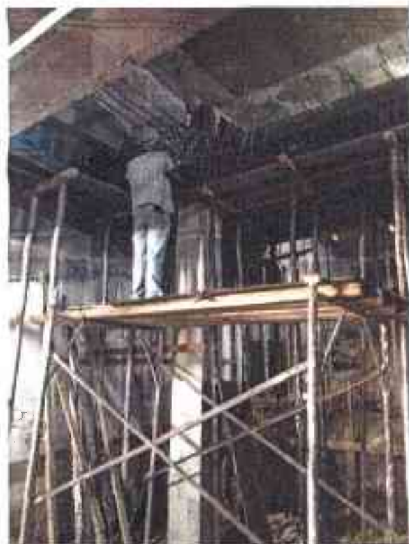
Figura 30 – Reforço de viga no 1º subsolo
