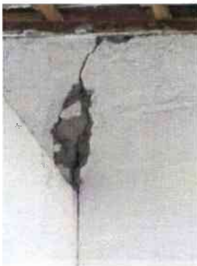
Figura 9 – Esmagamento da alvenaria
