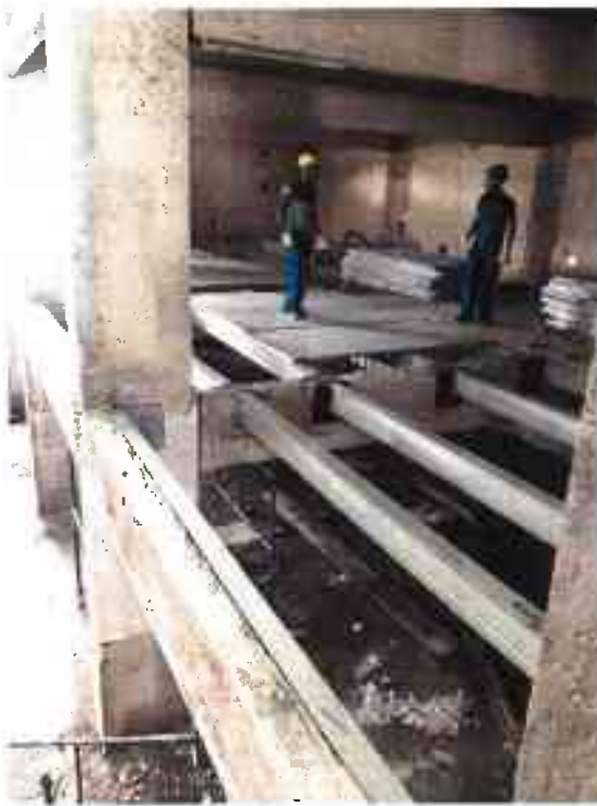
Figura 39 – Detalhes construtivos dos subpavimento utilizando perfis metálicos
